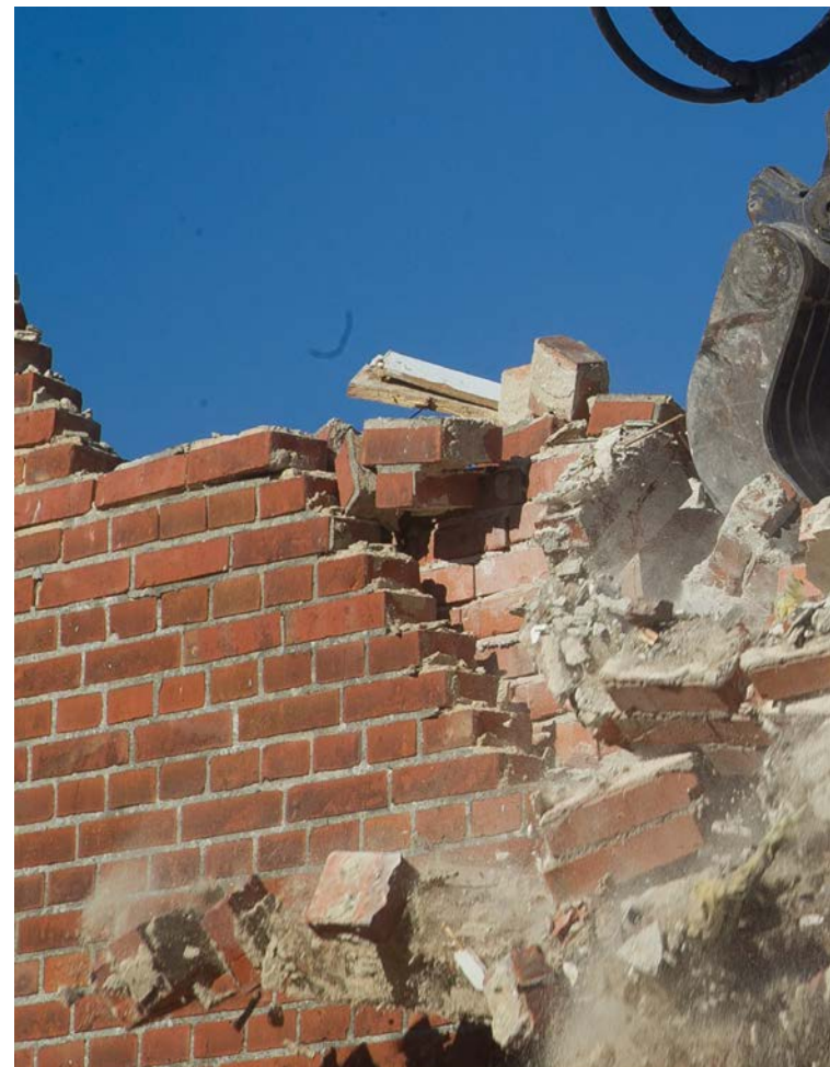
Det var stort set en tom skal, der stod tilbage, da grabben blev sat i for at vælte huset omkuld. Foto: Steen Don
